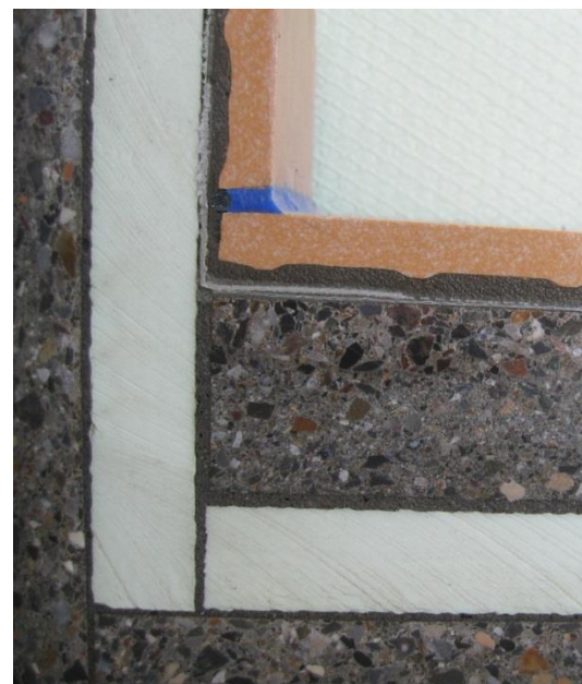
Pravilna montaža traku na balkonu.
